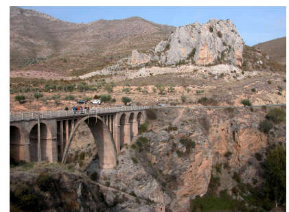
Vistas desde el pueblo a la carretera
